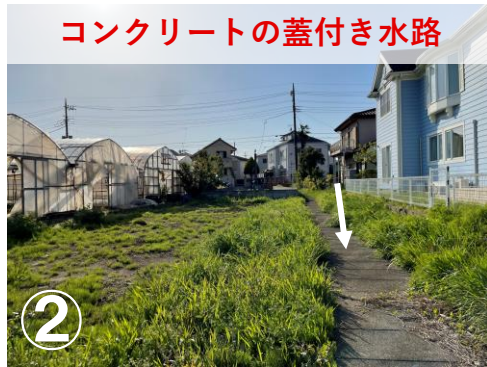
② コンクリートの蓋付き水路
